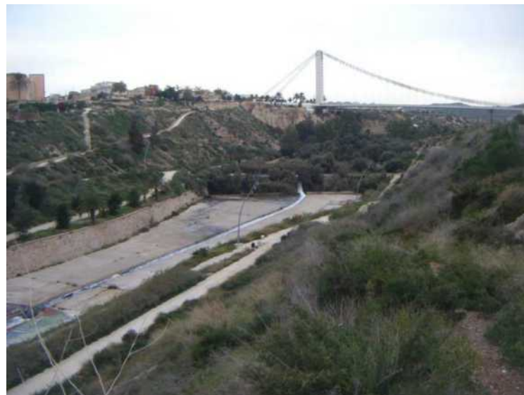
Azud de inicio y Puente del Bimilenario. Fuente: Ecologistes en acció de Alicante / Margalló Ecologistes en acció d'Elx. Plan de naturalización y restauración ambiental del río Vinalopó a su paso por Elche
