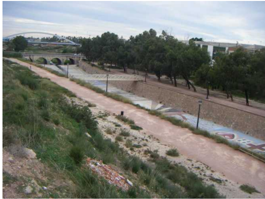
Puente de Barrachina. Fuente: Ecologistes en acció de Alicante / Margalló Ecologistes en acció d'Elx. Plan de naturalización y restauración ambiental del río Vinalopó a su paso por Elche
