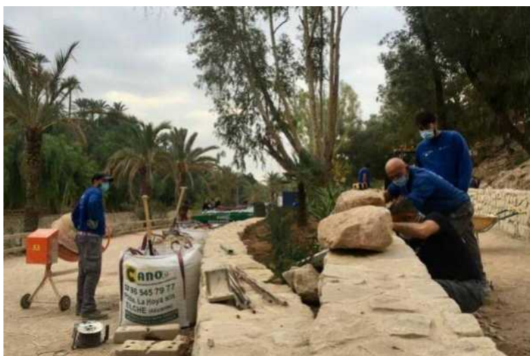
Talleres de empleo realizando trabajos de consolidación. Fuente: https://alicantepalza.es/elche-creara-un-corredor-recreativo-deportivo-que-unira-el-pantano-con-el-hondo-a-traves-del-cauce-del-vinalopo
