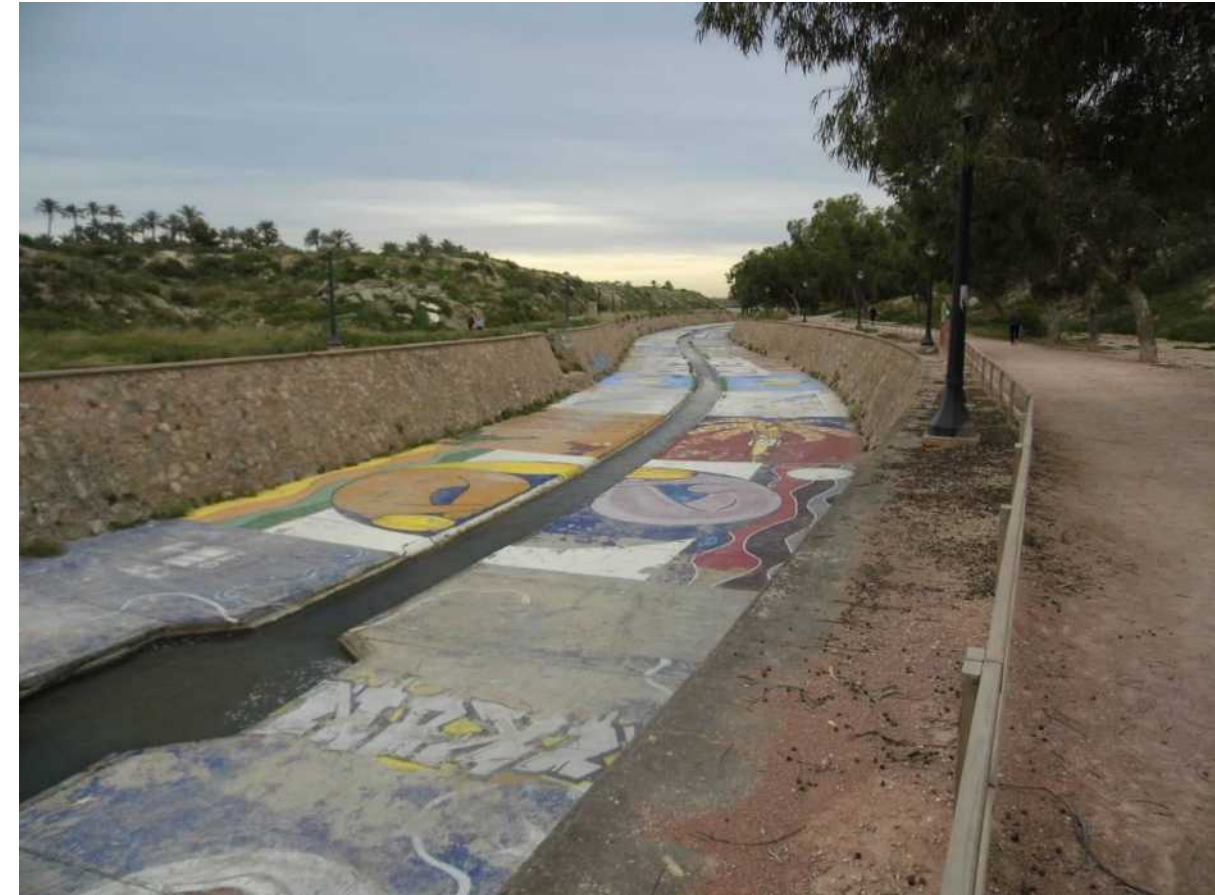
Aguas abajo del Puente de la Generalitat. Fuente: Ecologistes en acció de Alicante / Margalló Ecologistes en acció d'Elx. Plan de naturalización y restauración ambiental del río Vinalopó a su paso por Elche
