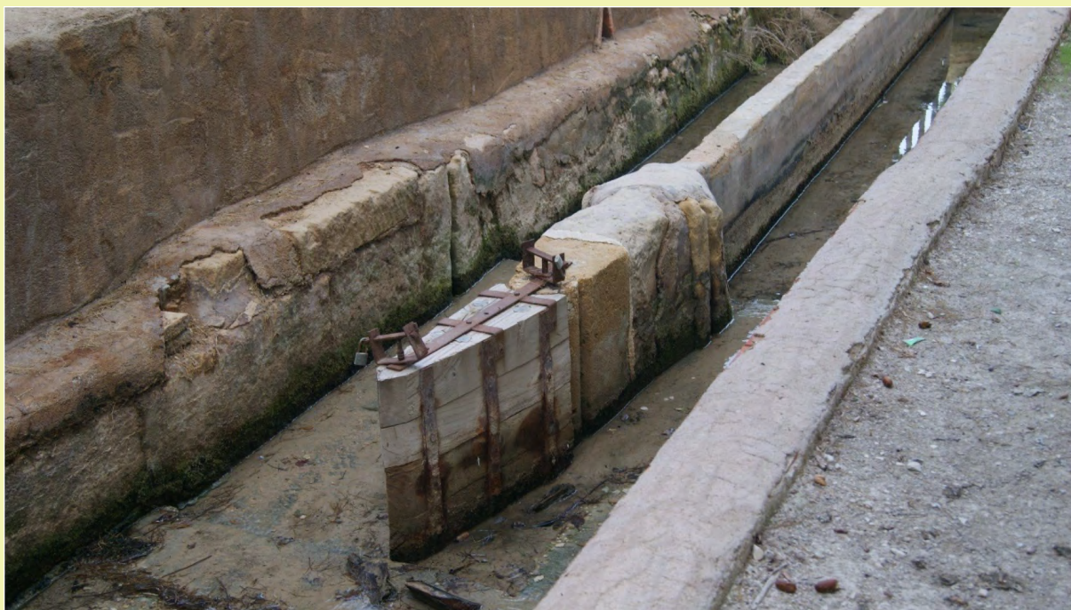
Detall d'una séquia amb els partidors mòbils per a la distribució de l'aigua.
