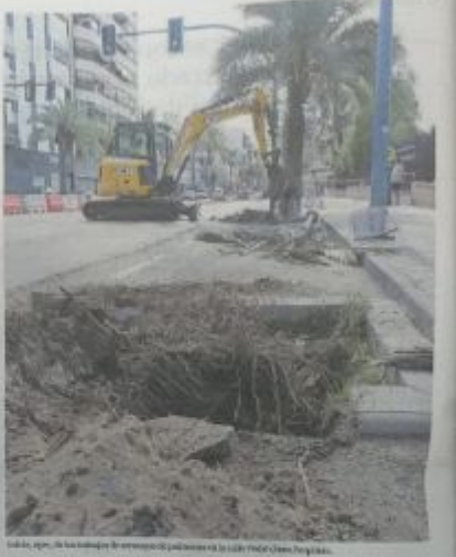
Una zona de obras de mantenimiento de las calles de Elche.
